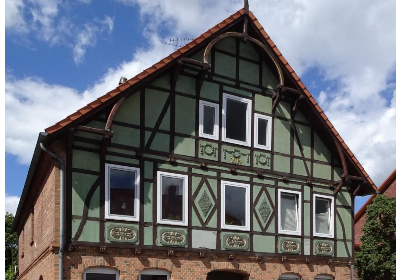
Beispielhafter Dachüberstand, Schützenstraße 2
