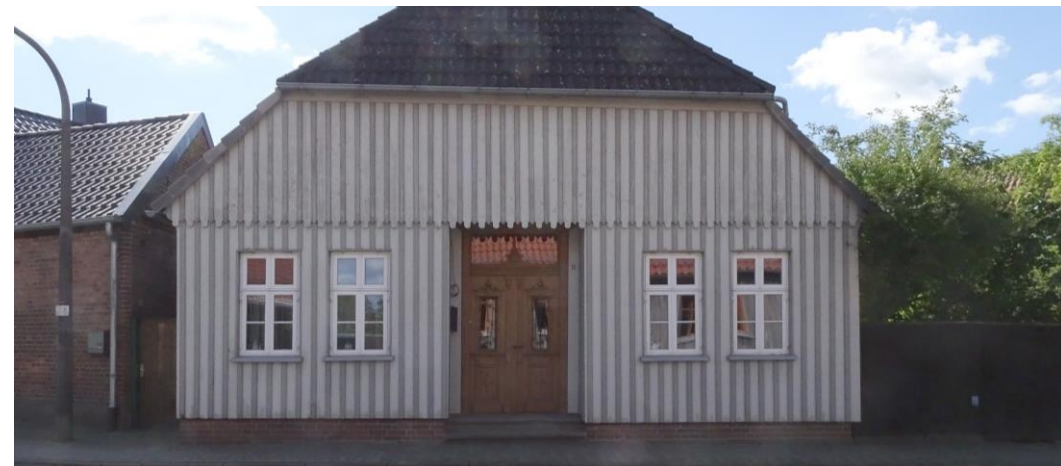
Verkleidung mit senkrechter Deckelschalung, Marktstraße 15
