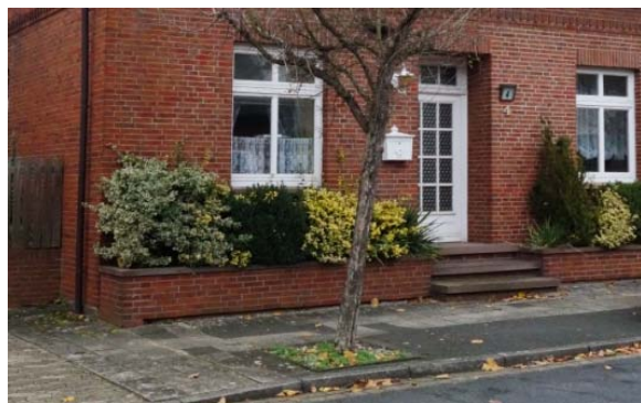
Abschnitt 2: östlich Lindenstraße
