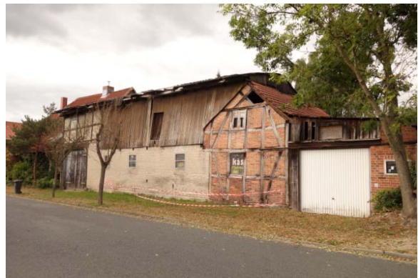
Abschnitt 1: fehlende Gehwege
