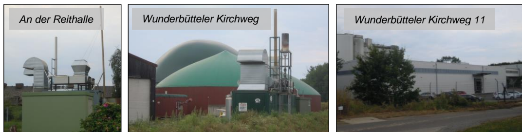
Abbildung 9 Gewerbeanlagen südlich des Plangebiets 'OHE-Gelände' (Fotos: GeräuscheRechner, 2020)
