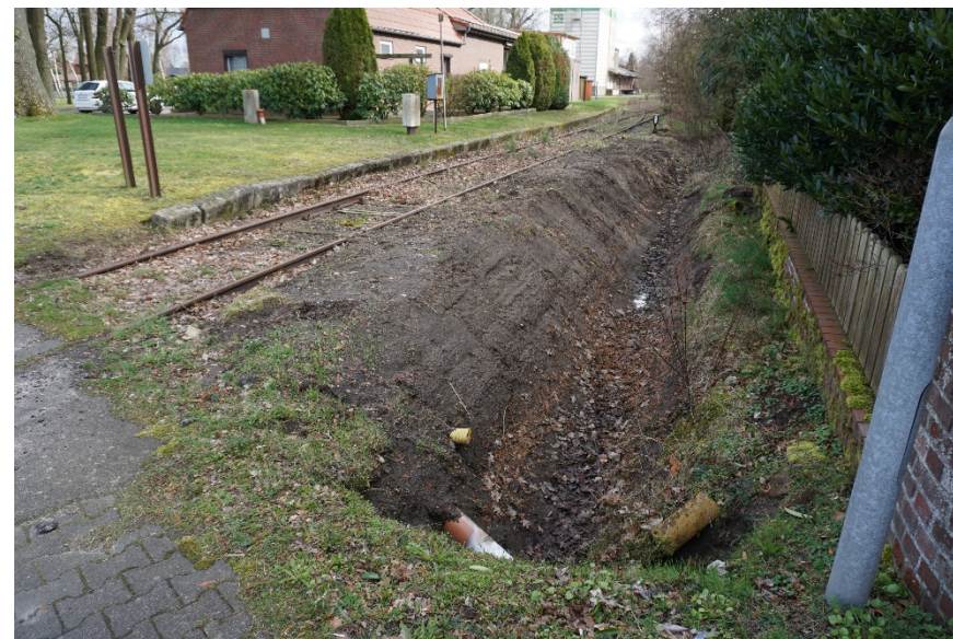
Abbildung 63: Bahnhof in Suderwittingen als möglicher Zwischenstopp einer Draisinenstrecke
